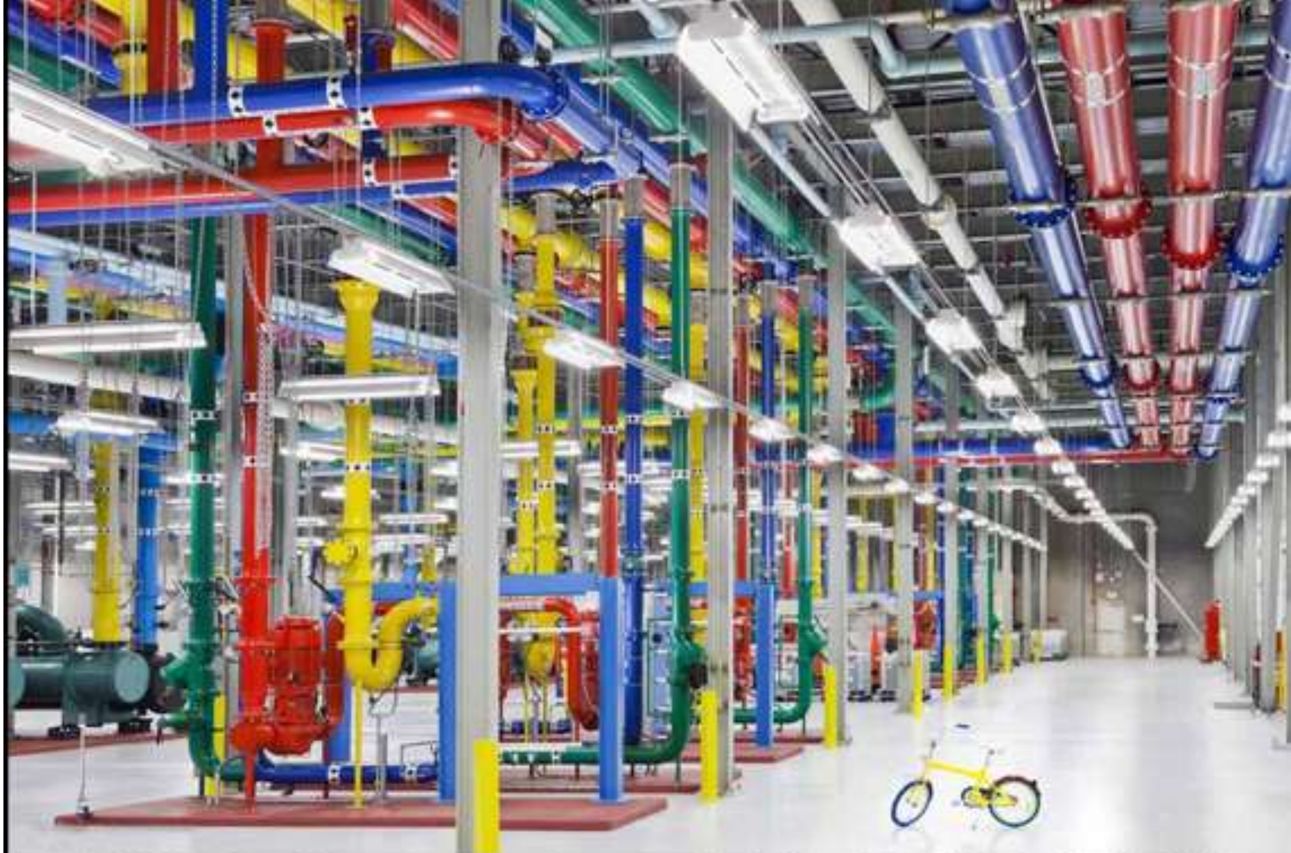
A vízhűtés csővezetékei az atlantai szerverközpontban. A különféle színek a víz hőmérsékletét és folyási irányát jelzik, a méretekhez jó összehasonlítási alapot nyújt a folyosón hagyott bicikli - ilyenekkel közlekednek a mérnökök az óriási szervertermekben.
